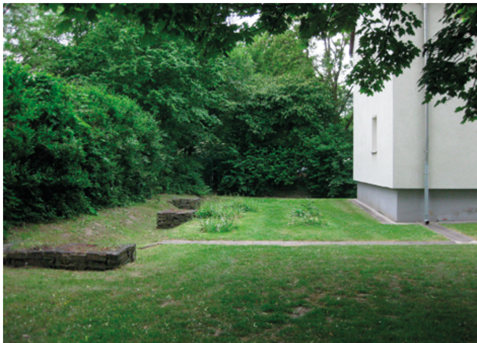
Abb. 93: Gartenanlage mit offenem Regenabfluss und Sickermulde
